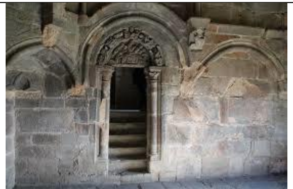
Escalera de subida a la Cocina de la Reina
