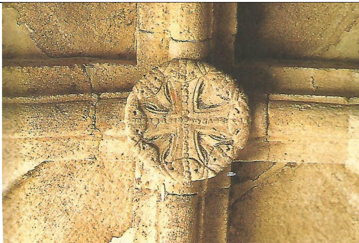
Sala Capitular. Detalle de la clave de la bóveda.
