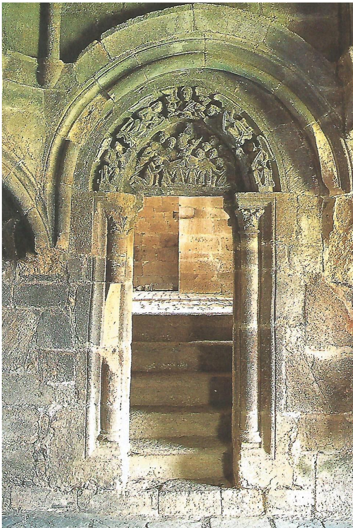
Escalera de acceso a la Cocina de la Reina
