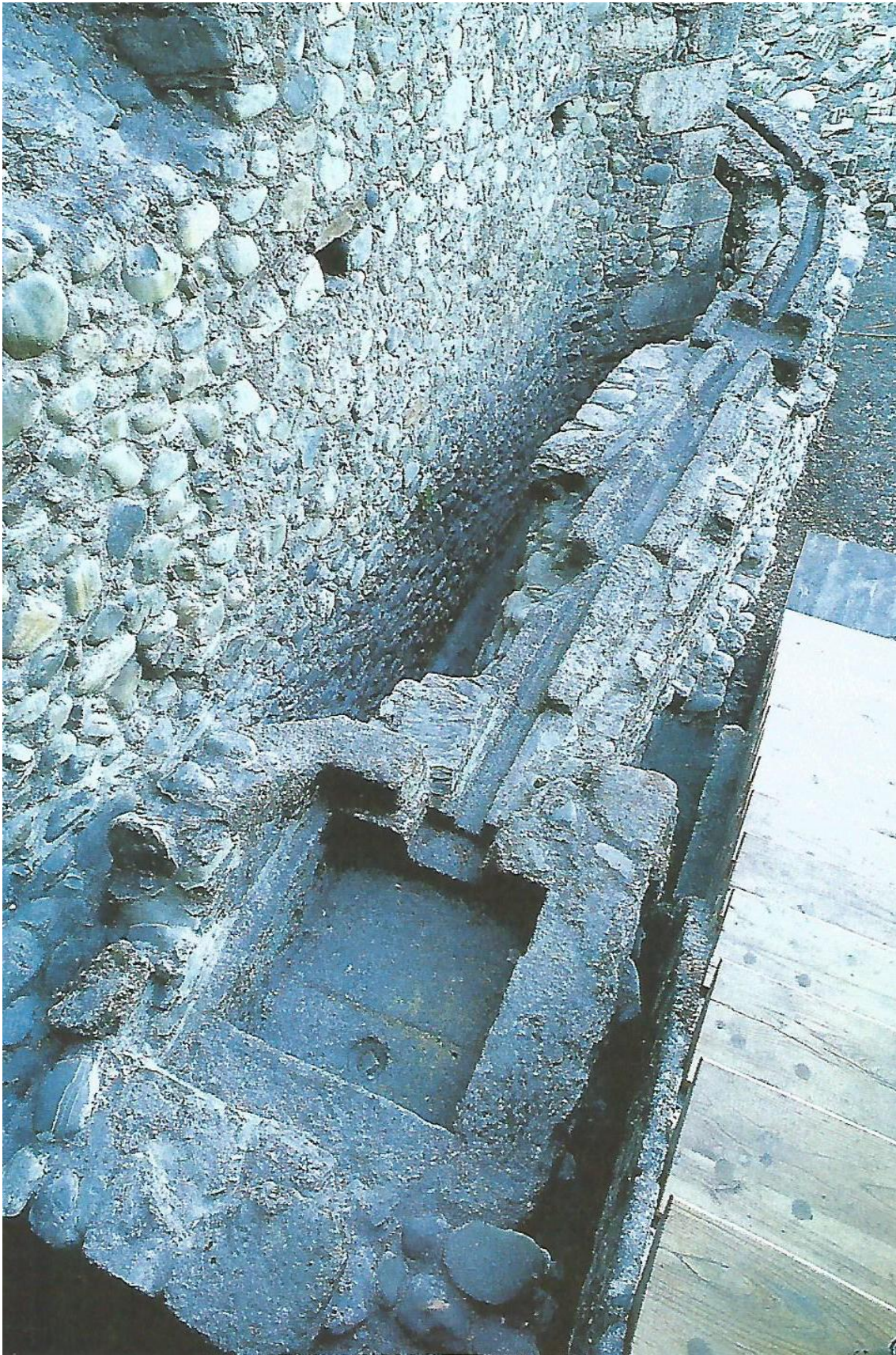
Sistema hidráulico de Carracedo. Imagen 1.
