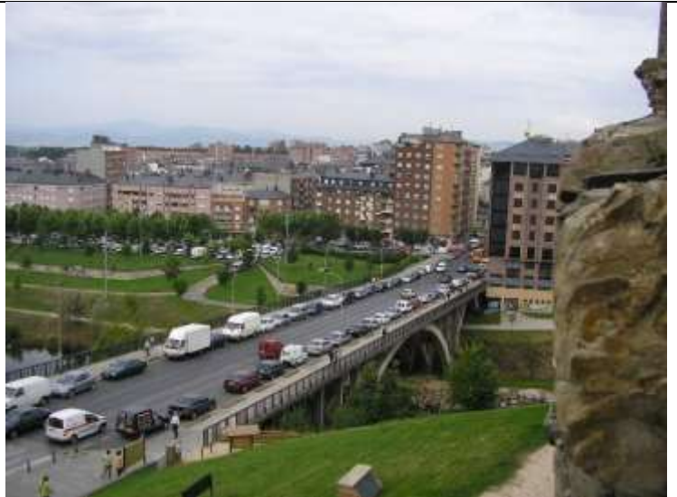
Vista del Puente García Ojeda, desde la Torre de Moclín
