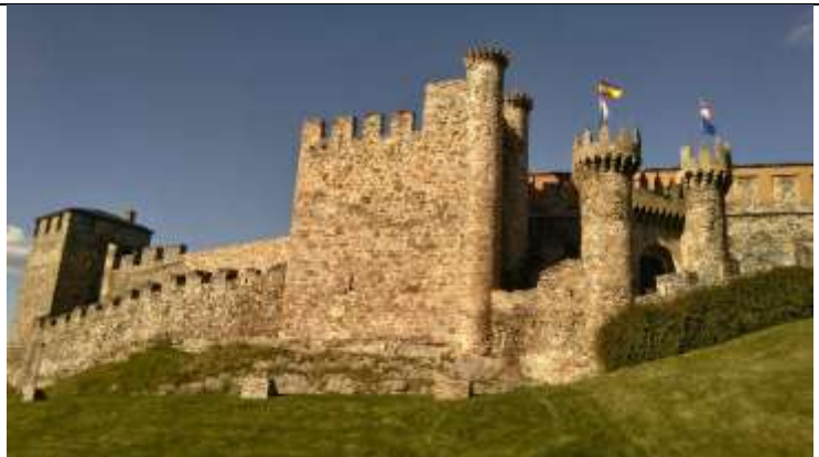
A la izquierda Torre de Moclín
